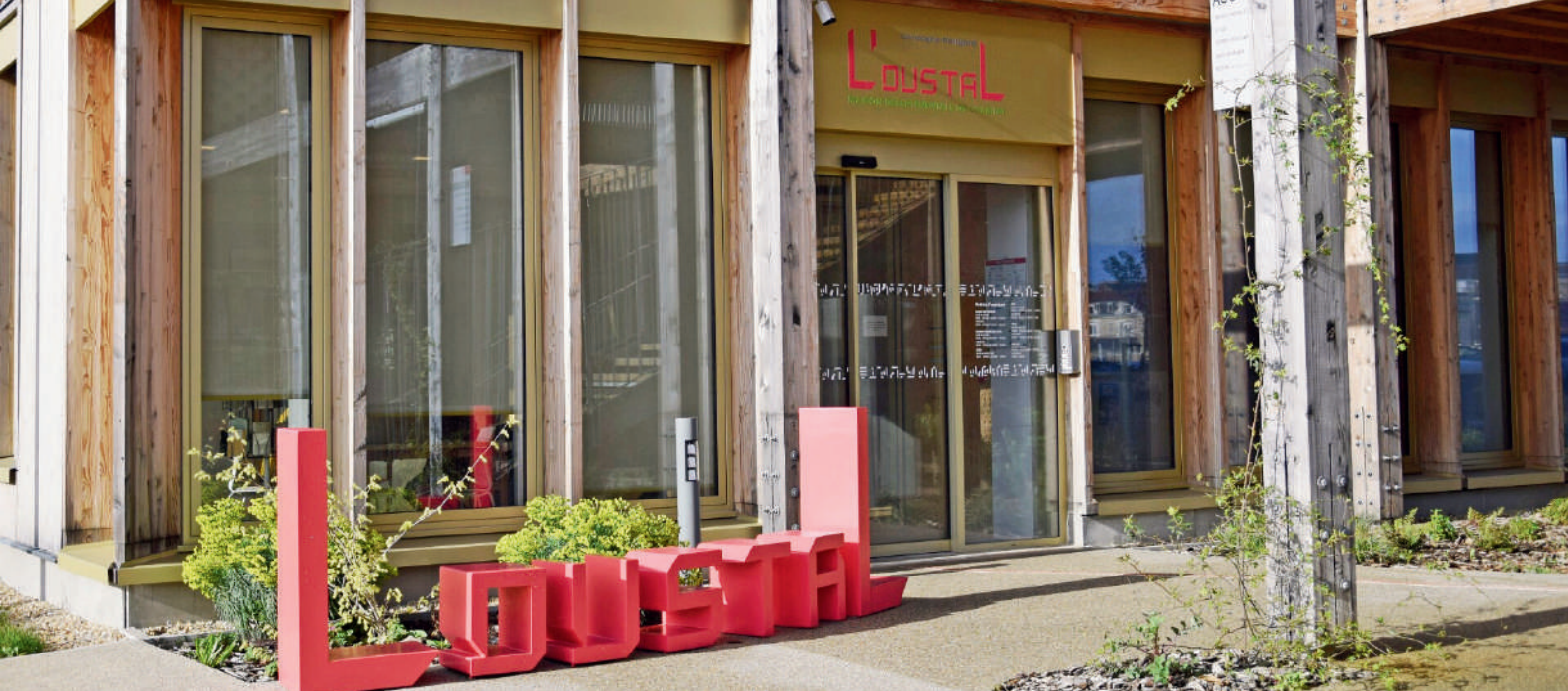
Entrée visiteurs du bâtiment Nord hébergeant Terren Périgord
